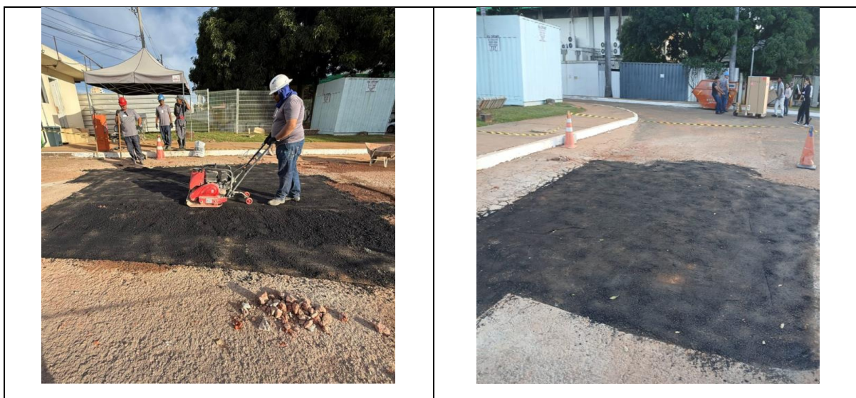
Imagens 02 – recomposição de manta asfáltica na entrada de serviços da unidade
