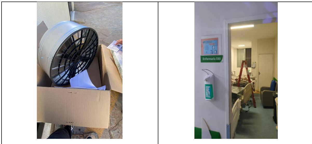
Imagens 01 – troca dos ventiladores de exaustão da cozinha e revisão de toda a iluminação dos andares
